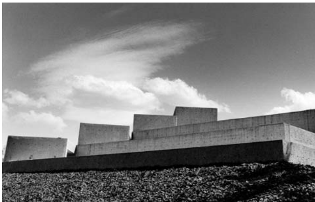
Figura 9: Edificio modular en varios niveles (Fot.: Museo Tamayo)
