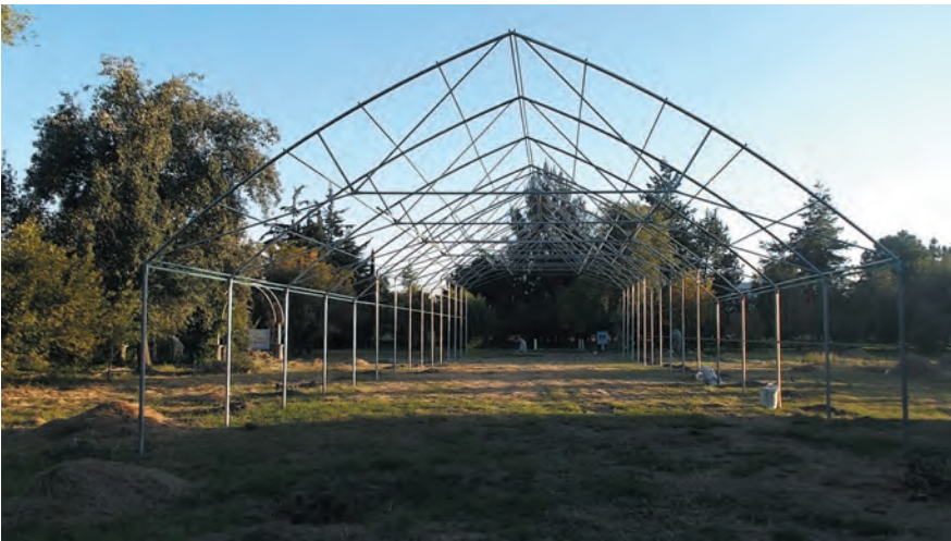
Conservatorio en construcción. Foto: Archivo FESC-UNAM
